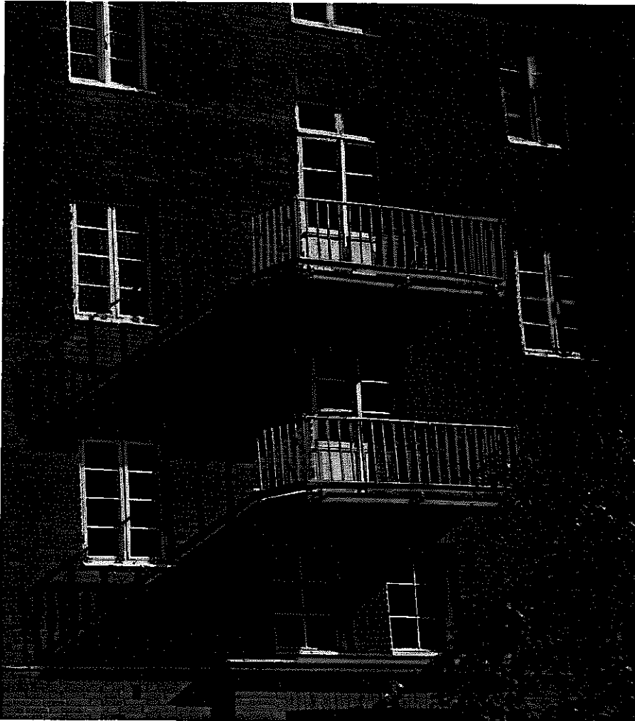
Skugga från befintliga trapphusbalkonger på gatuhuset. Väl värt att notera är att de är 1,0 m djupa. Föreslagna balkonger innehar ett djup på hela 1,4 m.
