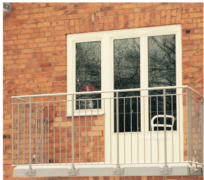
En ny balkong från Balcona i jämförelse (standardutförande och med en annan typ av fönsterdörrar än våra)
